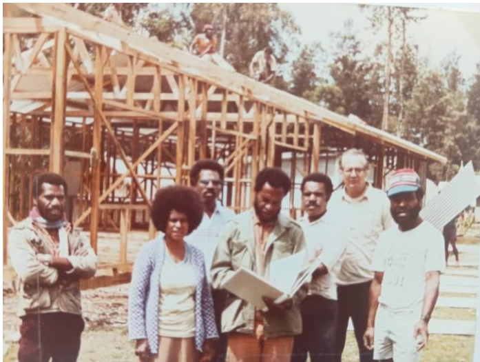
Theo met enkele leerkrachten voor een dubbel schoollokaal in aanbouw (1984)
