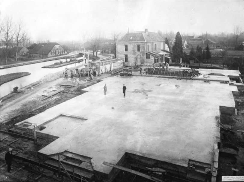
De fundatie van de H. Jacobuskerk. Gedaan door N.V. Betonmaatschappij Bogram van Eeten en de Bruyne. Op de voorgrond de hoofdlineans met het nortaal en op de achtergrond de pastorie. Op de foto is goed te zien dat men met een schuit gemakkelijk bouwmaterialen kon aanvoeren. Foto uit 1927. (Coll. A. van Rossum)
